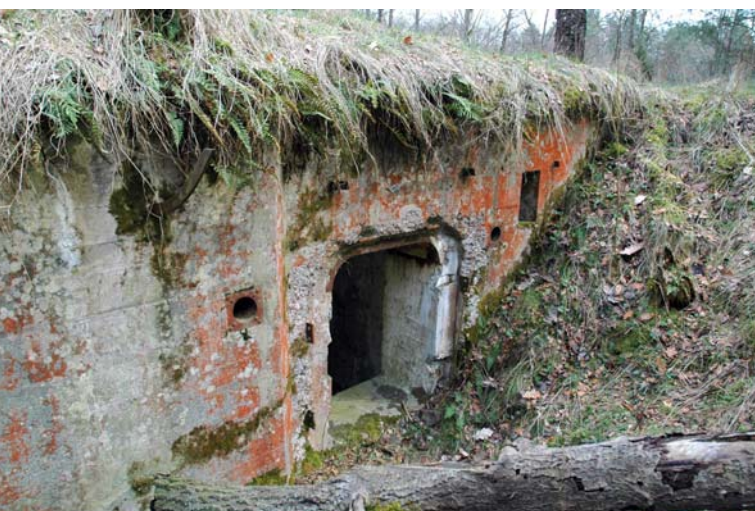
Obiekt nr 2 - Jedno z dwu wejść do schronu - widoczne czerpnie powietrza starego typu, pałki do zawieszenia siatki metalowej oraz nisza przyłącza telefonicznego (po prawej). Kolor pomarańczowy to nie pozostałość maskowania...
