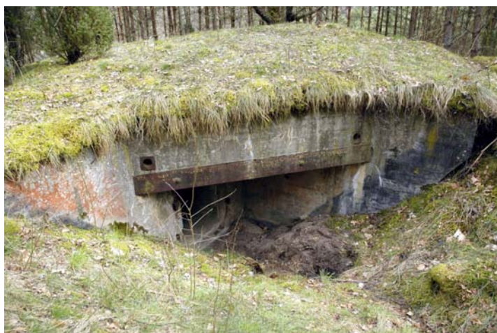
obiekt nr 1 – wejście osłonięte betonowym okapem
