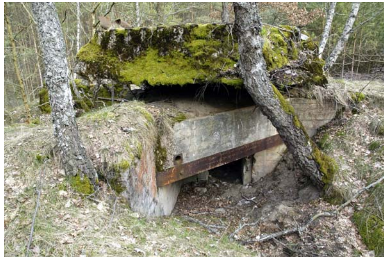
Obiekt nr 5 - Elewacja wejściowa. Wybuch wewnątrz pomieszczenia bojowego spowodował odrzucenie fragmentu stropu obiektu
