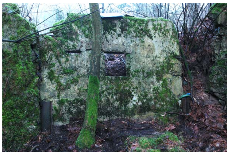
stanowisko ckm z 1934 roku – zachowane żelbetowe wzmocnienie ściany czołowej z profilem przeciwykosztetowym osłaniające niegdyś płytę stalową o grubości 4 cm - Pommernstellung, teren Drawieńskiego Parku Narodowego
