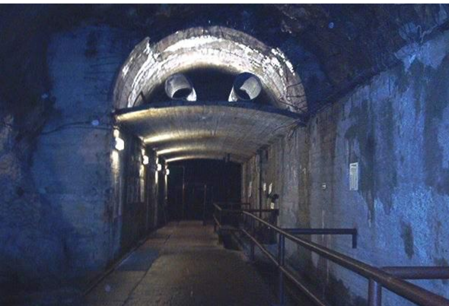
Kompleks Rzecznka – część obetonowana z widocznymi rurami wentylacyjnymi
